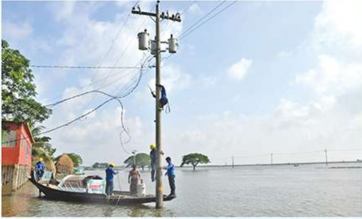
হাওর অঞ্চলে আলোর ফেরিওয়ালার মাধ্যমে ট্রান্সফরমার পরিবর্তনের কাজ করছে কিশোরগঞ্জ পল্লী বিদ্যুতের “আলোর ফেরিওয়ালার” কর্মীরা
